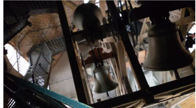
Bild 12: Glockenstuhl beim Läuten
