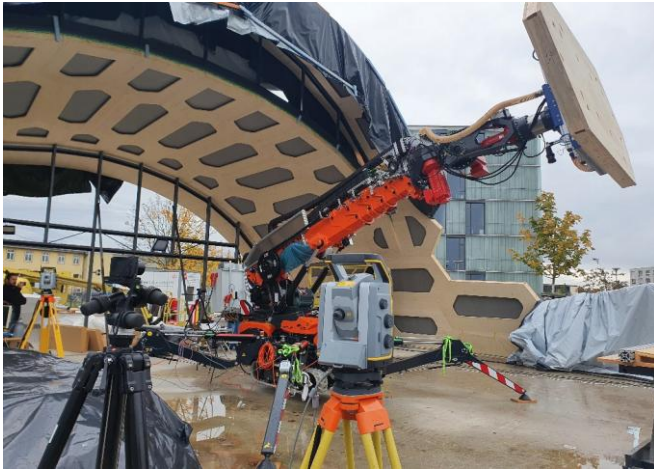
Kran / Roboter A
